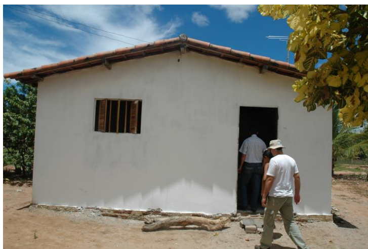
Figura 5 – Exemplo de casa entregue pelo INCRA antes do momento da reforma.
