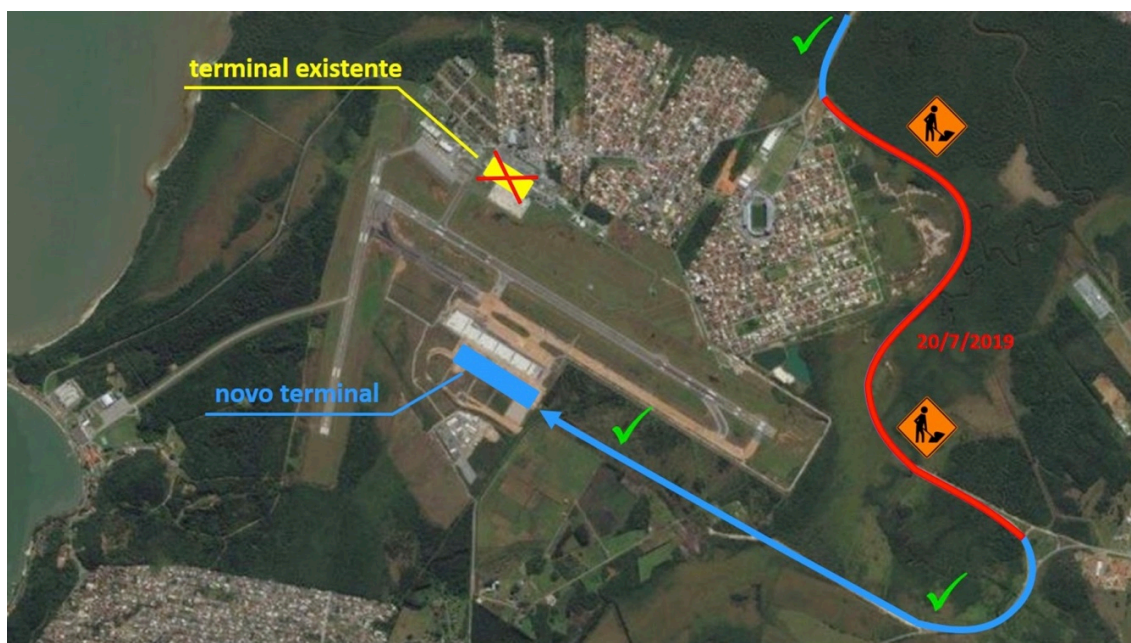
Fig. 2. Obras do novo Aeroporto Internacional Hercílio Luz
