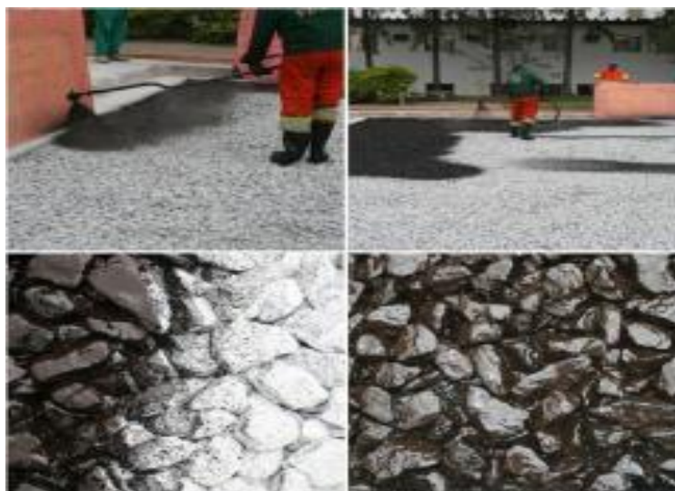
Figura 17: Aplicação de imprimação
