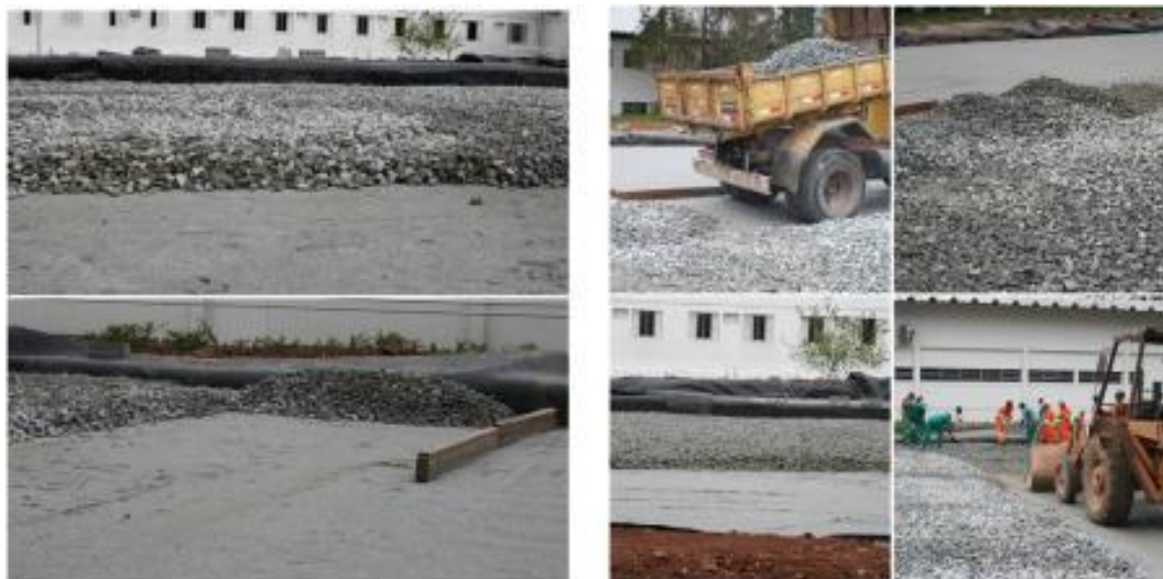
Figura 15: Espalhamento de macadame hidráulico (pedra 3)
