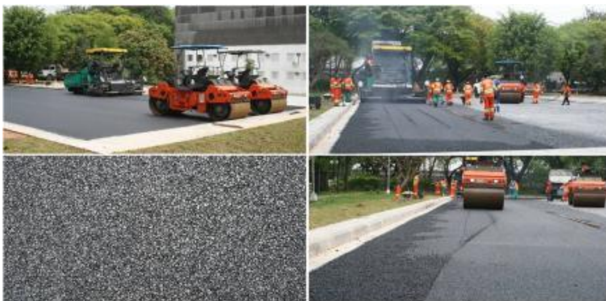
Figura 18: Execução do revestimento
