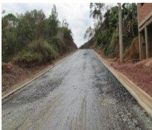
Figura 6: Imprimação impermeabilizante
