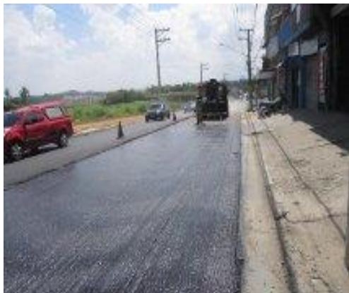
Figura 8: Imprimação Ligante
