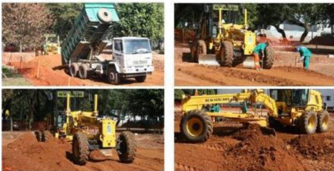
Figura 13: Espalhamento e nivelamento de solo para reforço
