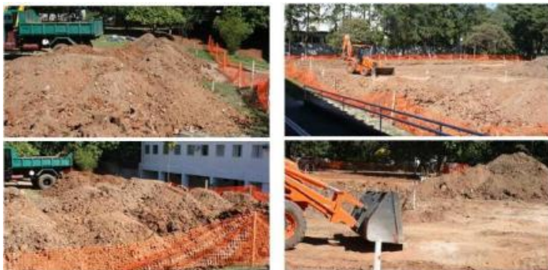
Figura 12: Terraplanagem - preparação para o aterro
