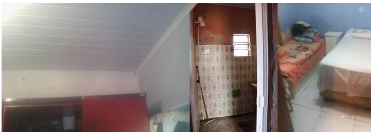
Figura 8: Imagens do forro colocado, do banheiro reformulado e do novo piso dos quartos. Fonte: ASCPOA.
