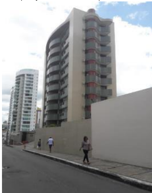
Figura 18: Constituição da Rua Ana Maria da Silva Brasileirinho e padrão de muros implantados nos edifícios verticais do Maurício de Nassau, causadores de sensação de insegurança e falta de vitalidade urbana, em comparação com a escala do pedestre.
