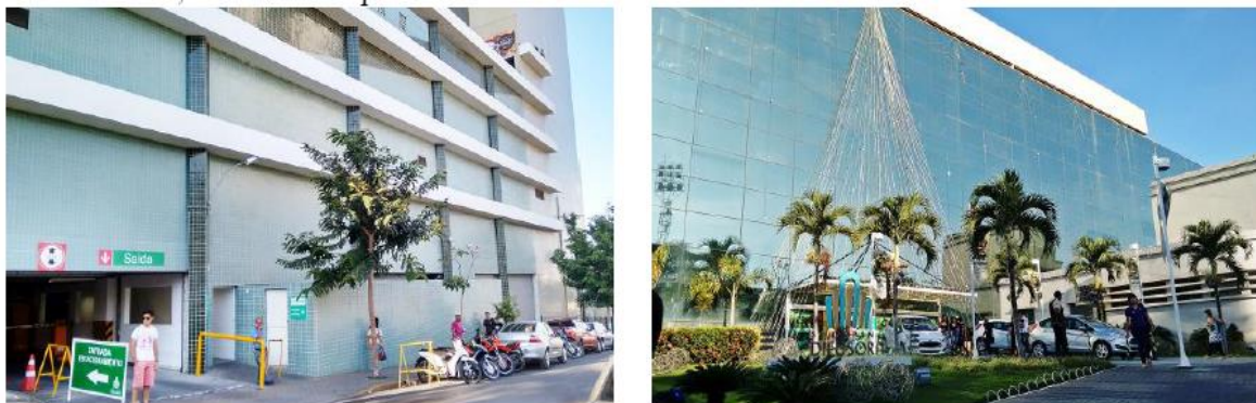
Figura 16: A esquerda fachada sul do Shopping e Empresarial Difusora com seu extenso paredão na via e a direita acesso principal ao Shopping no lado oeste, cuja fachada é revestida com vidro.
