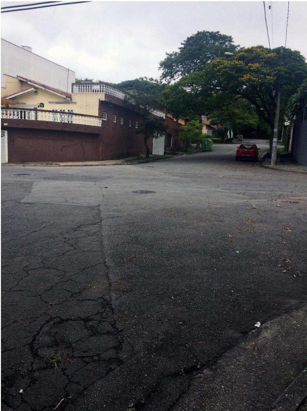
Figura 24: Fotografia mostra bloqueio retirado, ainda visível em remendo de asfalto. Fonte: Acervo do pesquisador.
