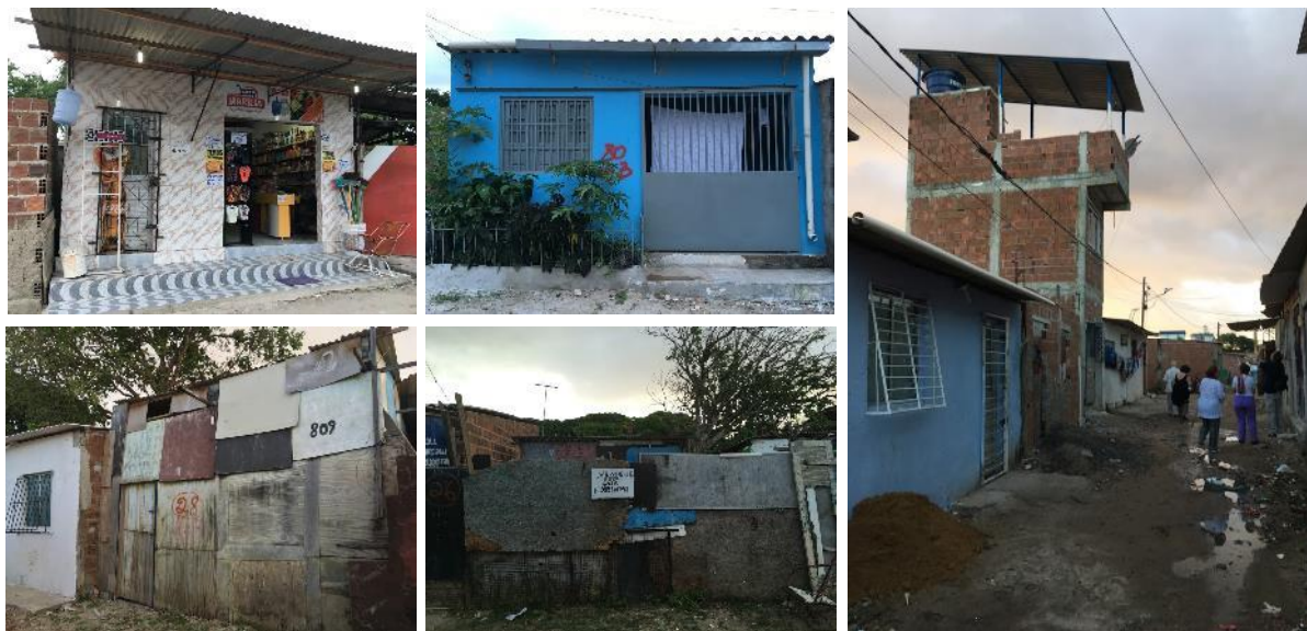
Figura 03 – Construções na Vila Sul
