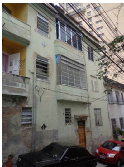
Figura 13: Edifício Multifamiliar da Ladeira João Homem nº 14 Fonte: VICTORINO, 2018
