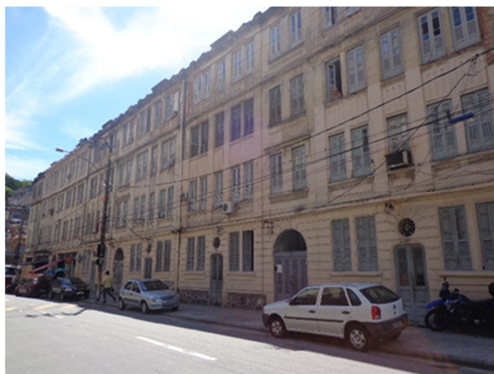
Figura 20: Edifício Multifamiliar da Rua Barão da Gamboa nº 164 – 178 Fonte: VICTORINO, 2018
