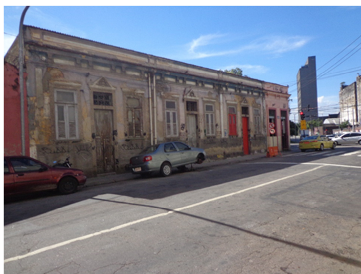
Figura 22: Casas da Rua Pedro Alves nº 4, 6 e 8 Fonte: VICTORINO, 2018
