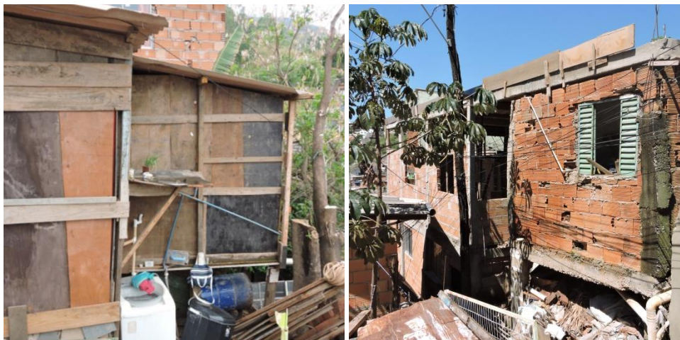
Figura 1 – Moradias autoconstruídas na Vila Acaba Mundo, em Belo Horizonte, MG.
