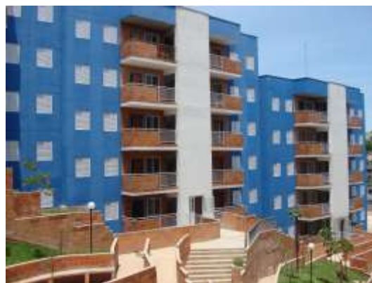
Imagem 5 – Empreendimento Patrimonial localizado no município de São Paulo. Programa Crédito Solidário. Empreendimento de pequeno porte com 96 uh. Assessoria técnica Ambiente. Fonte: acervo Ambiente.
