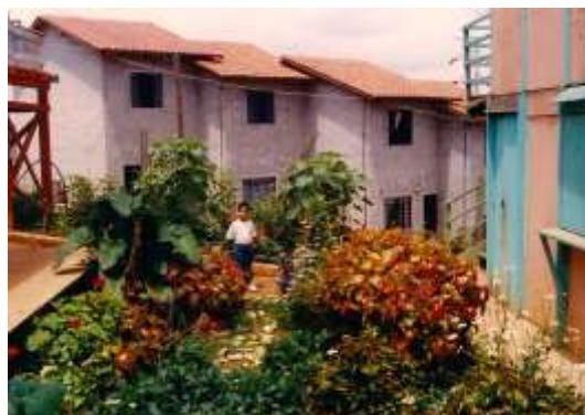
Imagem 2 – Empreendimento São Francisco I, II, III, IV e V localizado na zona leste do município de São Paulo. Programa de mutirão do município totalizando 808 uh. Assessoria técnica Ação Direta AD. Fonte: acervo Labhab FAUUSP.
