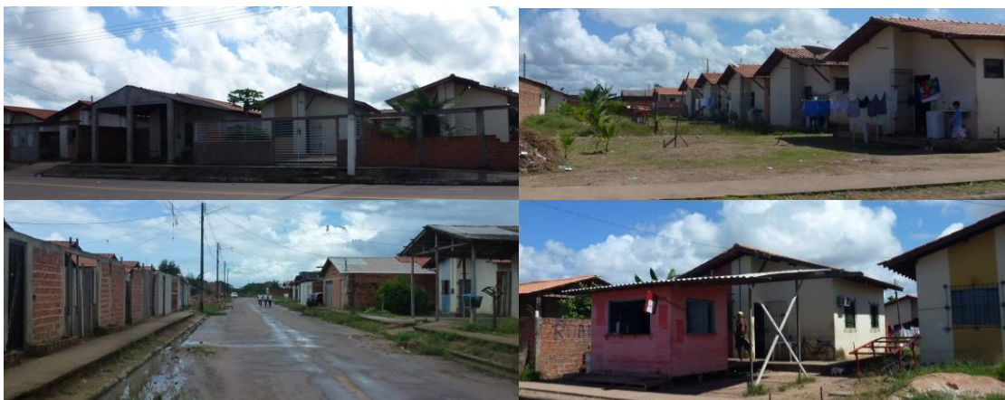
Figura 6 - Conjunto Habitacional Mestre Oscar Santos: obras avançando nos passeios públicos; ausência de divisas entre as residências; ausência de arborização urbana e passeios públicos inacessíveis, além de recorrentes problemas na rede de esgotamento sanitário; abertura de comércio locais. Fotos: acervo ATAU, 2016.
