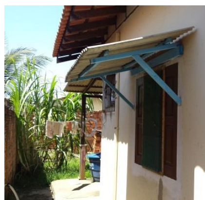
Figura 23 – Troca de esquadria e construção de beiral para evitar insolação direta no ambiente feita pela moradora. Foto: Acervo ATAU, 2017.
