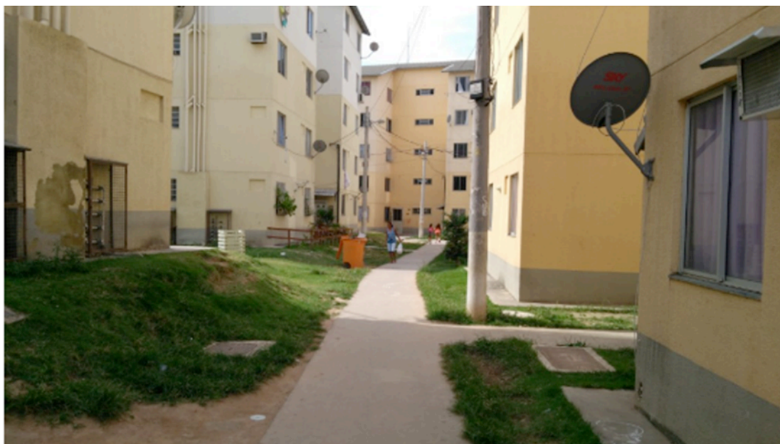
Figura3: Conformação diferenciada observada em ambos os condomínios do Conjunto Ismael Silva - Zé Ketí. Fonte: acervo pessoal, 2017.
