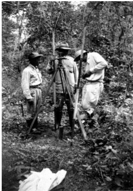
Eng. Emílio Noronha Figueiredo e auxiliares medindo terras em Panorama, 1946 (Acervo: Augusto Nadalutti)
