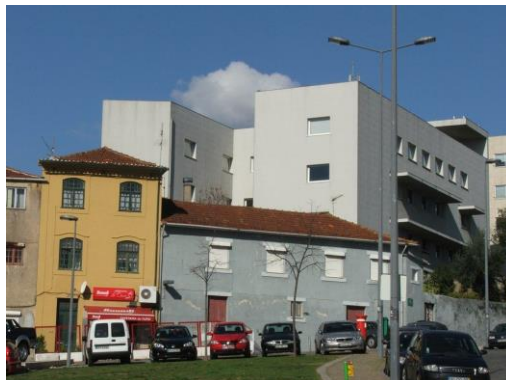
Imagem 01: Edifício de escritórios no Aleixo
