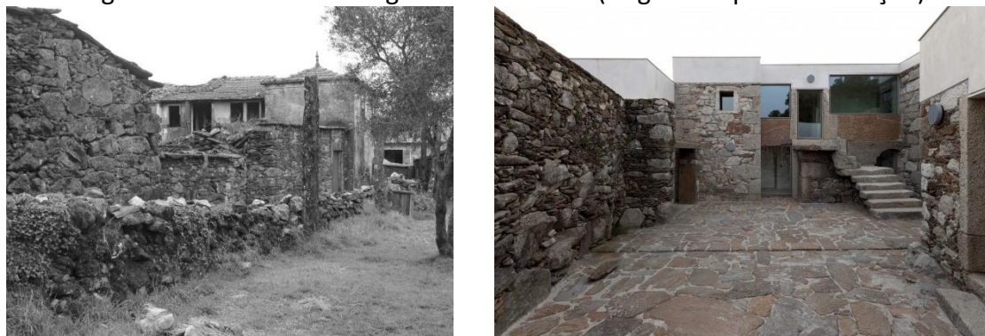
Imagem 35 e 36: Casa em Arga – Vista externa (original e após intervenção)
