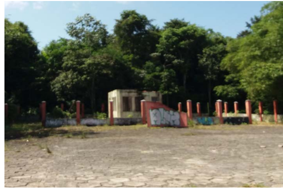
Ruínas da Guarita Av. Centenário
