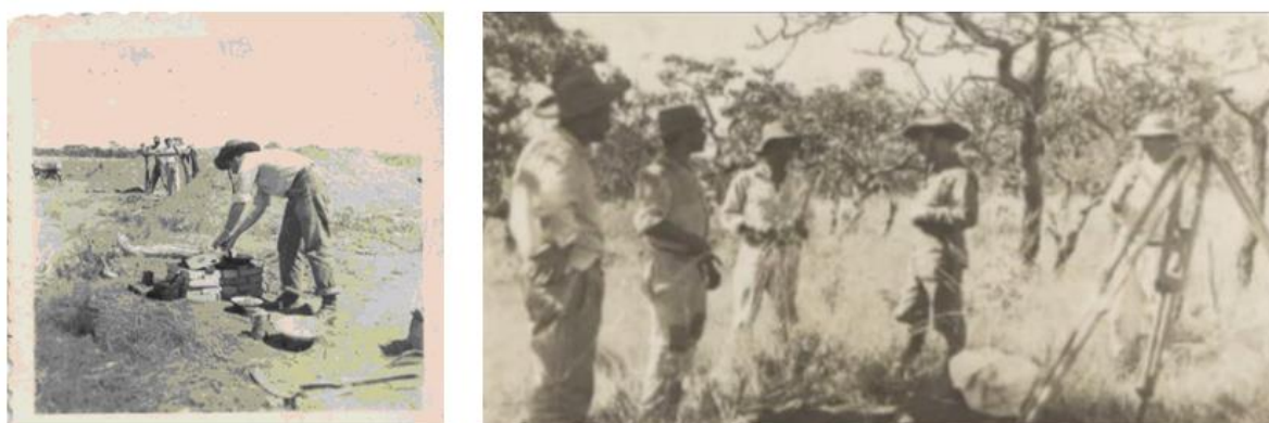
Fig. 5 - a) Colocação da pedra fundamental do município, em 1957, próximo à rodovia Brasília-Anápolis; b) Demarcação de vias da nova trama urbana no cerrado, em 1957.
