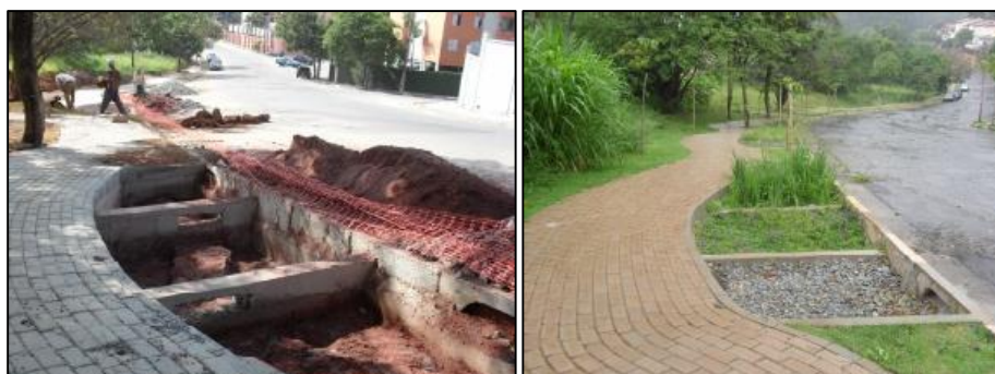
Figura 4 - Jardim de chuva no Horto do Ipê (SP): durante e depois das obras.
