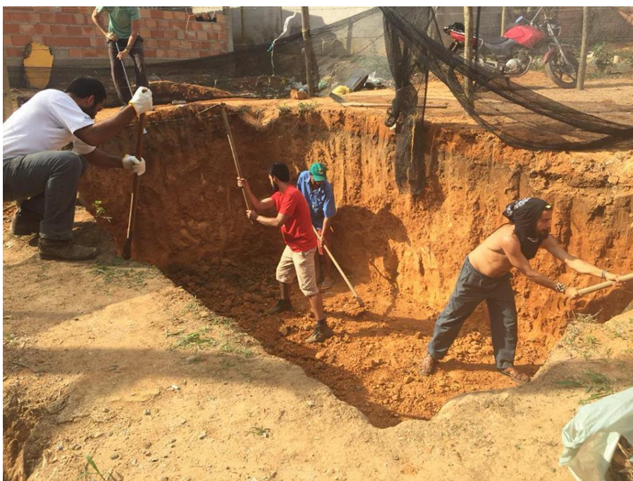
Figura 9: Mutirão para nivelamento do Tanque de Evapotranspiração.
