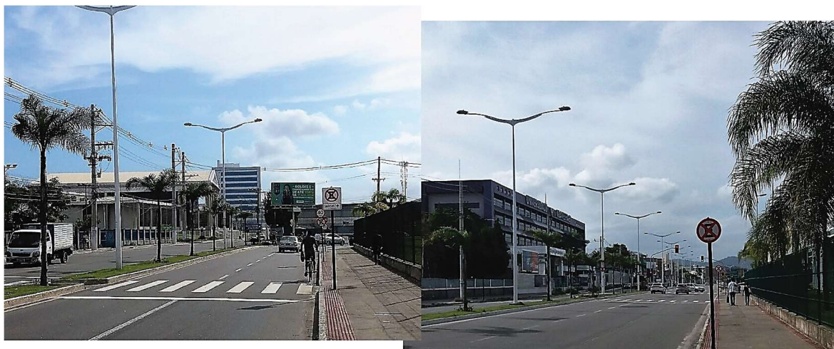
Figura 10 – (esq.) Vista da Av. Luciano das Neves, via arterial e de grande fluxo em dias úteis; na margem esquerda, ao fundo, o Fórum da cidade; à direita, o ponto de confluência com a Rua Juscelino Kubistchek (Fig.11); (Fonte: acervo pessoal)
