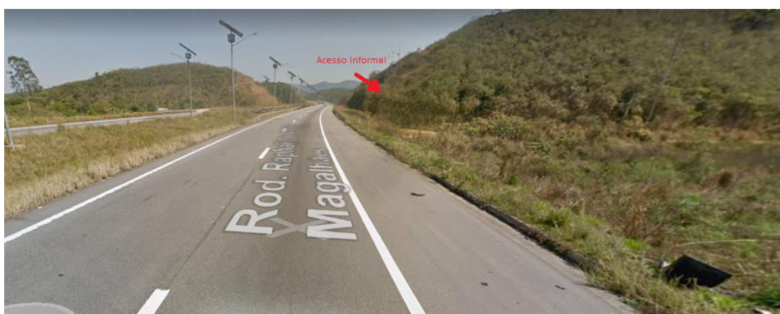
Figura 52 – Acesso informal no Município de Queimados.
