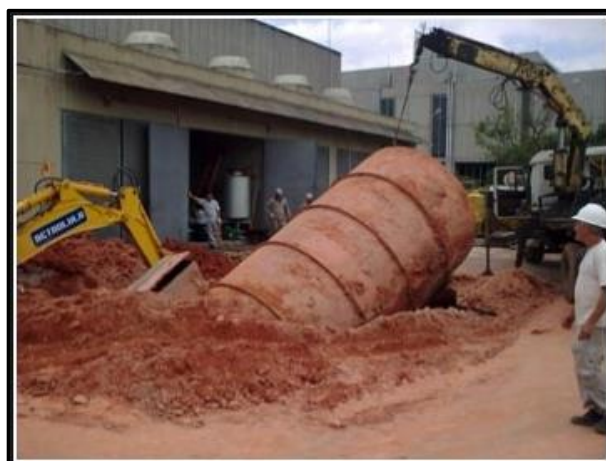
Figura 4: Remoção de Tanque enterrado
